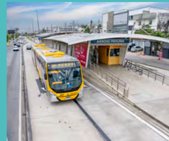
Estação BRT Arroio Pavuna
